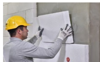
Izolacija termo mostova
