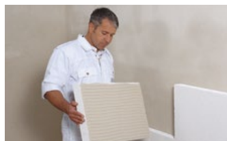
Termoizolacija zidova sa unutrašnje strane - ITICS
